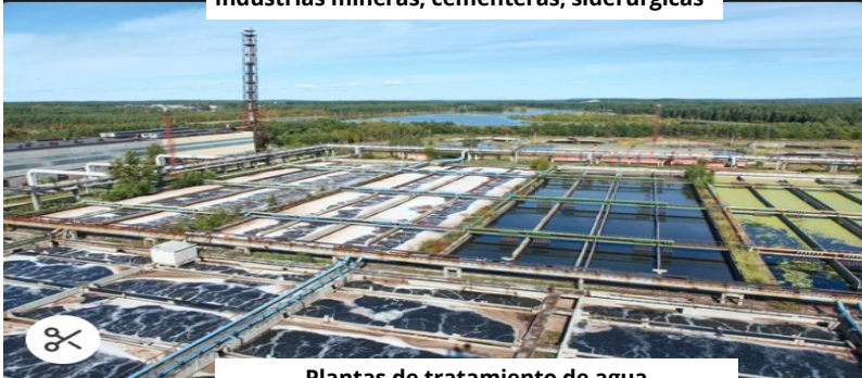
Plantas de tratamiento de agua
