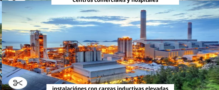
instalaciones con cargas inductivas elevadas
